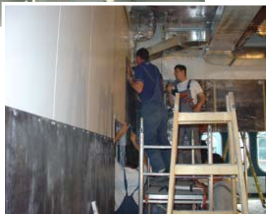
Oblaganje zidova olovnim limom
