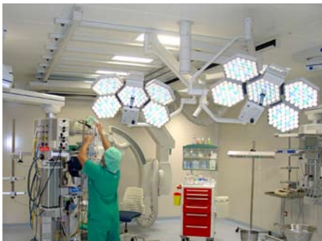
Angio operacijska dvorana
